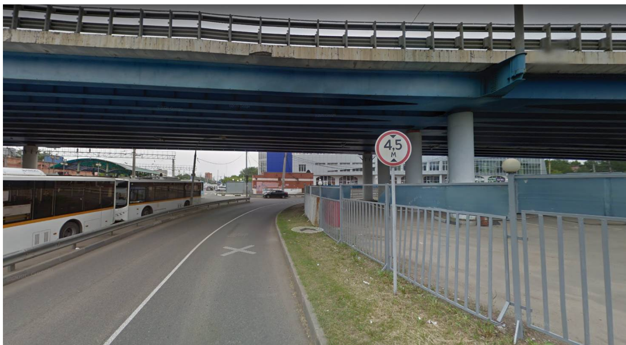
Рисунок 5 Маршрут испытаний, разворот под эстакадой
