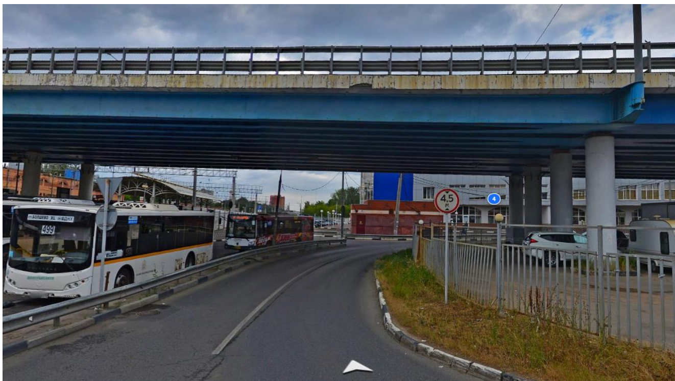
Рисунок 5 Маршрут испытаний, разворот под эстакадой у ст. Болшево
