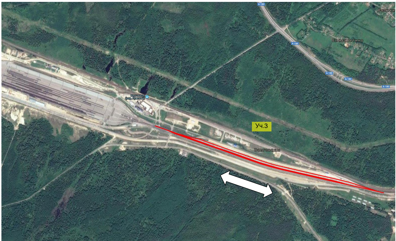
Рисунок 3 Маршрут движения тепловоза на станции Лужская (участок 3)
