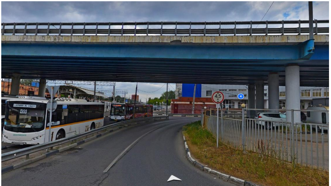
Рисунок 4 Маршрут испытаний, разворот под эстакадой
